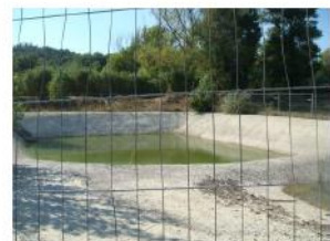
Bassin d'orage 700m 3
