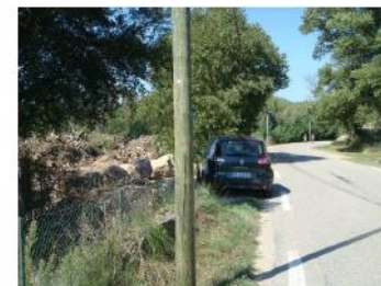
Route de Bozon avec ligne PTT
